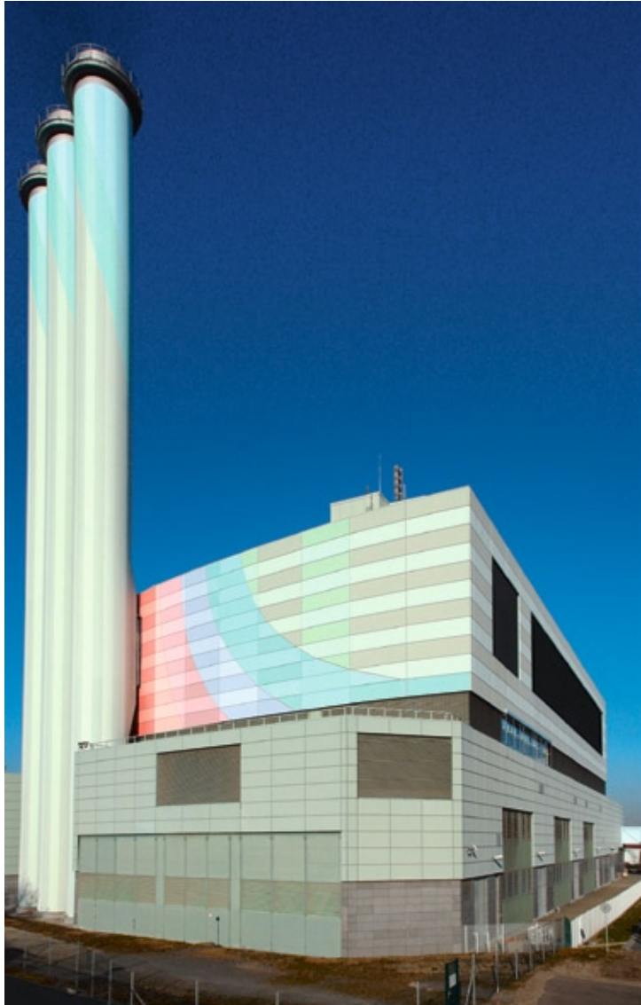
Abb. 1: Gasturbinen-Heizkraftwerk Nossener Brücke, Dresden
