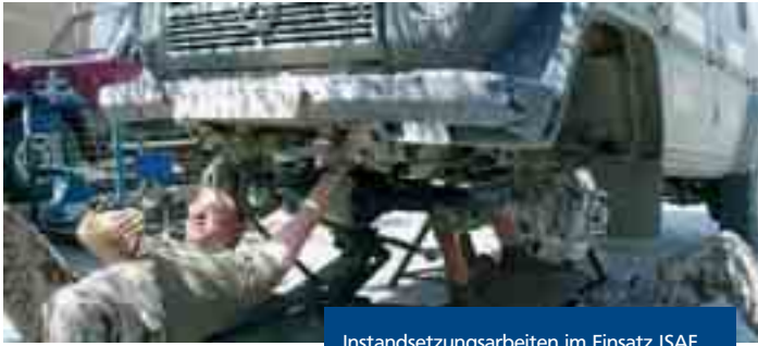
Instandsetzungsarbeiten im Einsatz ISAF
