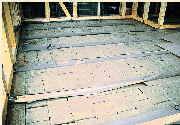
Die massiven Lehmsteine dienen zur Verbesserung des Schallschutzes der Holzbalkendecken.
