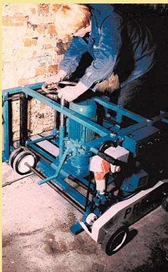
Beim Sägeverfahren übernehmen nach dem Einlegen der Dichtungsbahnen bis zur endgültigen Verpressung der Fugen Kunststoffkeile die Lastübertragung.
