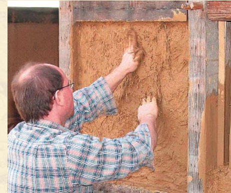
Das traditionelle Ausfachungsmaterial bei Fachwerkhäusern war Strohlehm, der handwerklich verarbeitet wurde.
