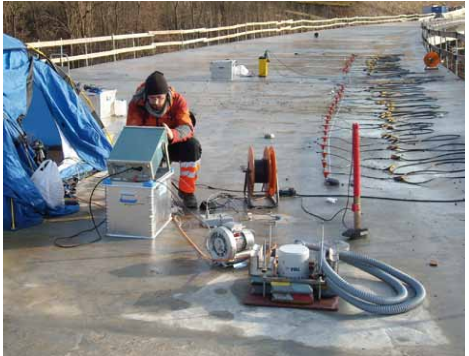
Vibrationsmessungen auf einem Brückenbauwerk
