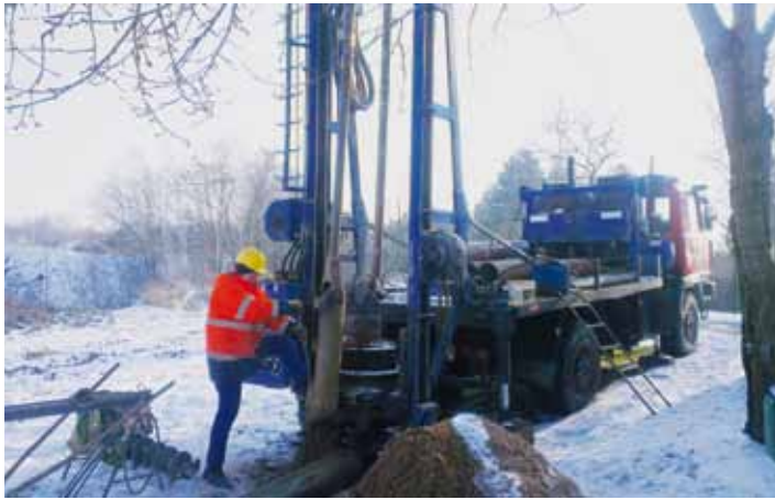
Bohrungen für Grundwassermessstellen
