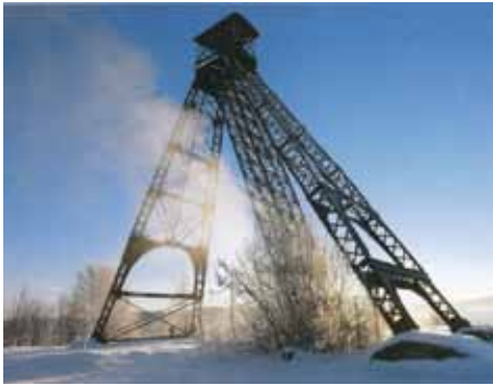
Förderschacht in Zschorlau
