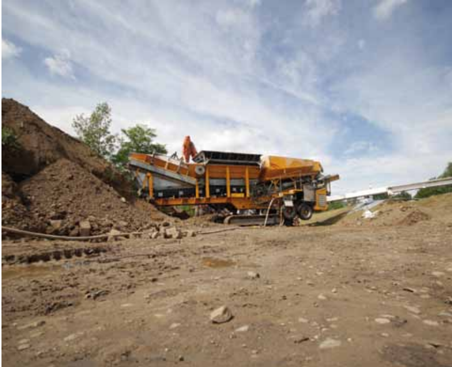
Mithilfe einer solchen Sternsiebanlage wird das vorhandene Bodenmaterial aufbereitet – um später zu Flüssigboden weiterverarbeitet zu werden, der auch natürliche Dichtungsmaterialien im Deichbau ersetzen können soll.
