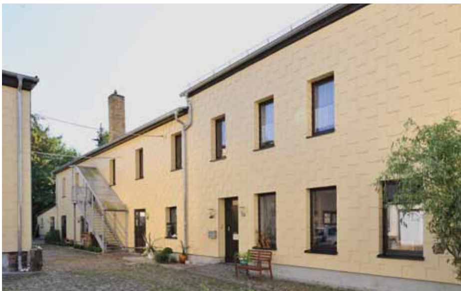
Saniertes Hauptgebäude der Firma
