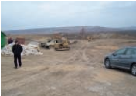
Baufeldvorbereitung im Dezember 2011
