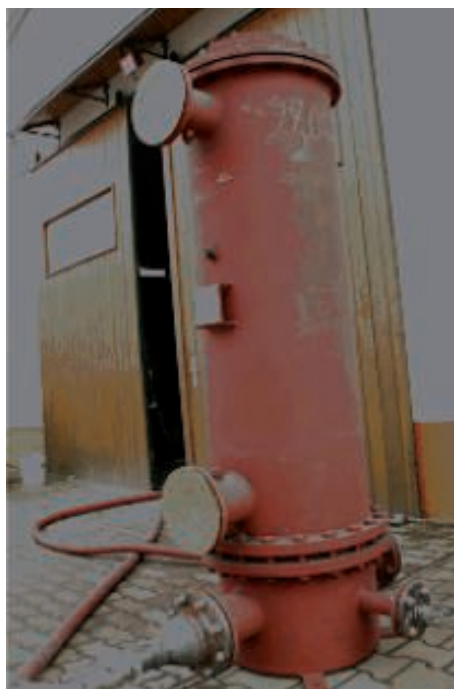
Innenreinigung eines Rohrbündel-Wärmeüberträgers
