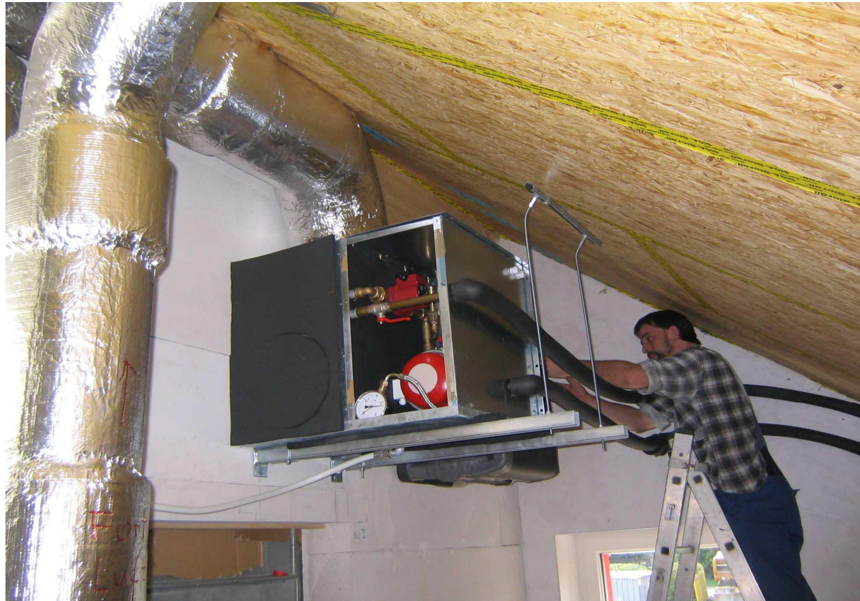
Passive Luftvorerwärmung Sole-Luft-Defroster
