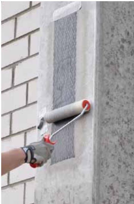
Einarbeiten des Sensortextils in Epoxidharzmatrix
