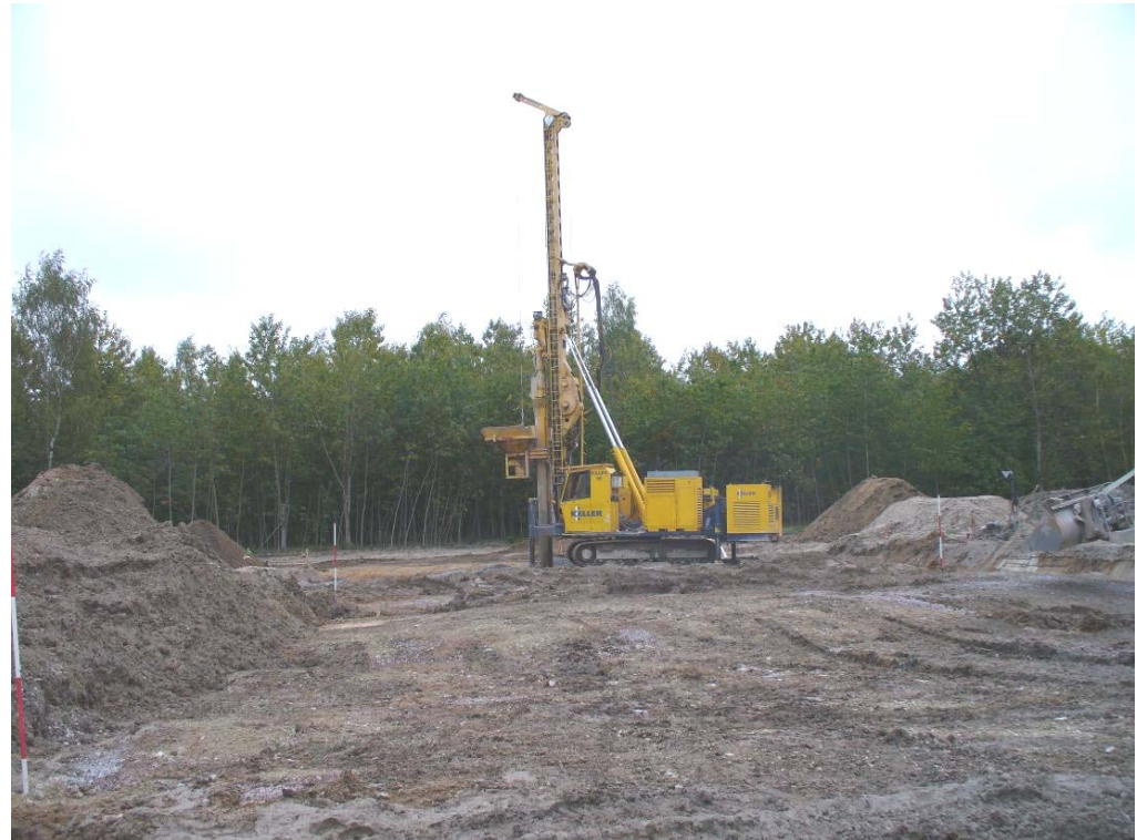
Einbringen von Rüttelstopfsäulen
